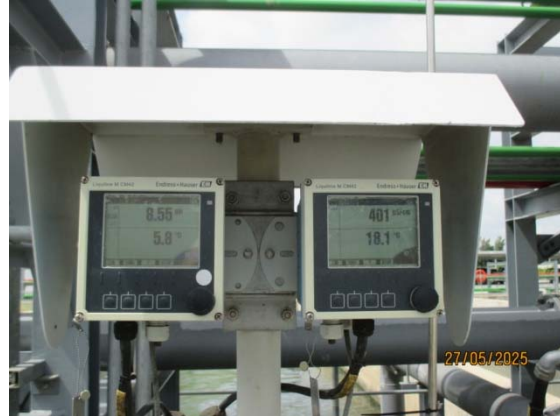
W2 : ระบบติดตามตรวจสอบคุณภาพน้ำแบบต่อเนื่อง (Online Monitoring) ของบ่อกักน้ำทิ้ง (Retention Pit)
