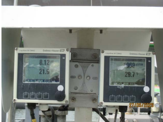
W1 : ระบบติดตามตรวจสอบคุณภาพน้ำแบบต่อเนื่อง (Online Monitoring) ของบ่อกักน้ำทิ้งจากหอหล่อเย็น (CT Blow Down Pit)
